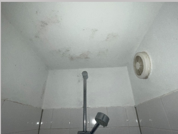
Dusche aus dem Erdgeschoss (oben), Frisch gestrichener Flur (rechts)
