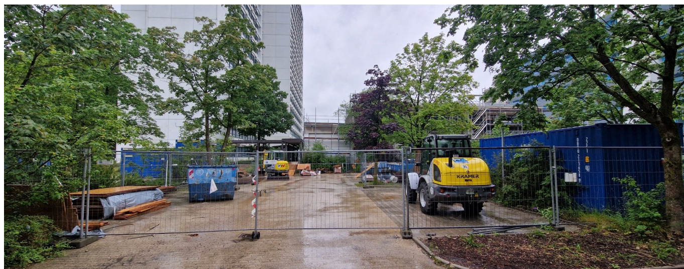
Die Baustelle hinter der Hans-Scholl-Halle
