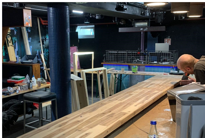
Das KADE während der Renovierungsarbeiten
