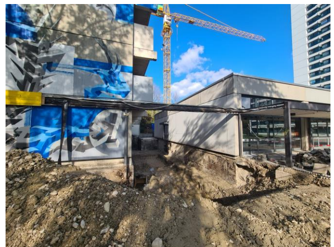
Zwischen Tribühne und Blauem Haus entsteht die Rampe zum Fahrradkeller
